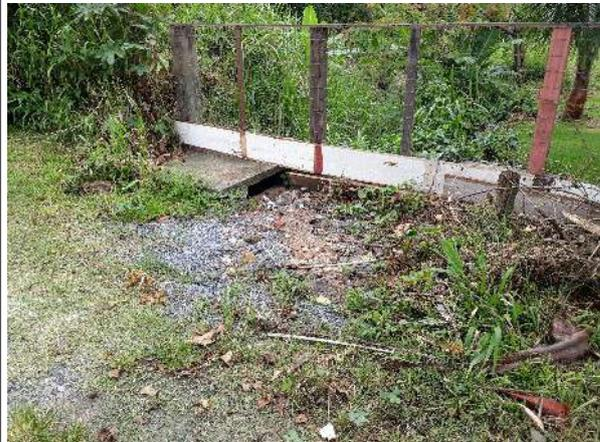
Figura 17 – Ponto de junção da drenagem pluvial com o curso d'água (trecho a céu aberto), com disposição irregular de resíduos sólidos domésticos e de construção civil
