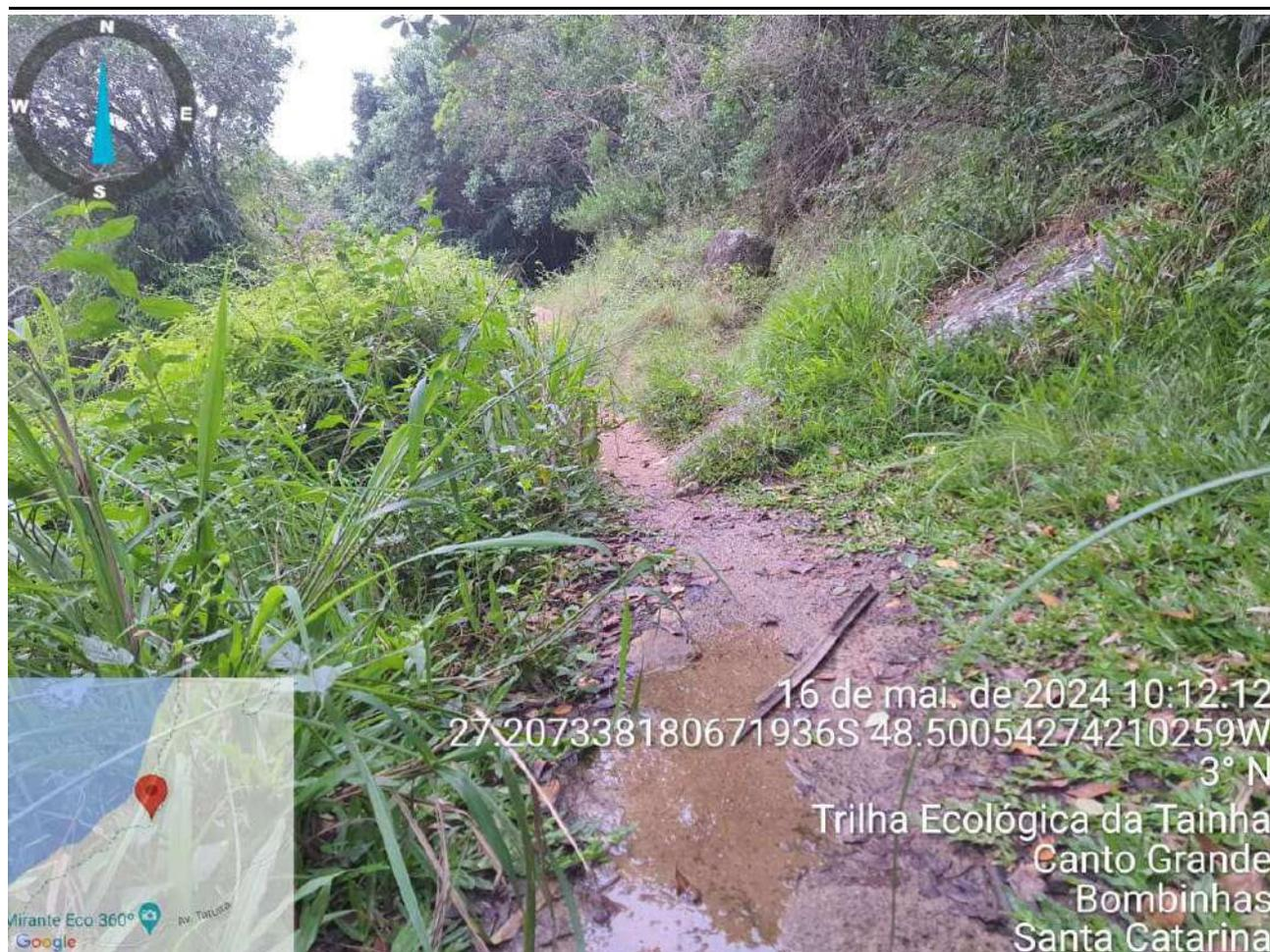
Será necessário promover por toda extensão da trilha a contenção do talude de madeira, buscado estabilizar o processo erosivo.
