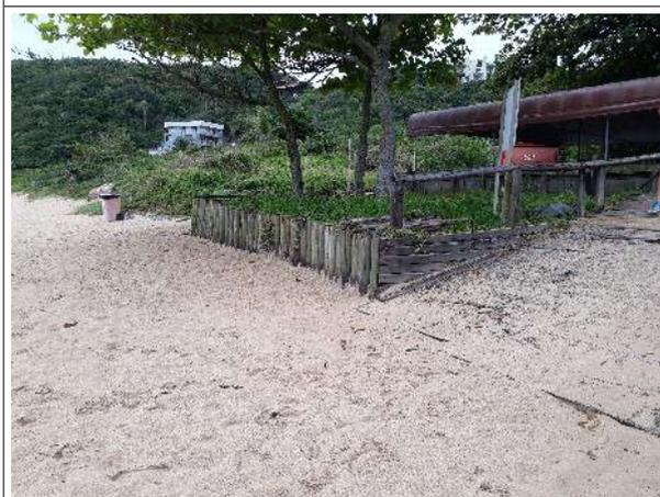
Figura 6 – Detalhe para instalação de mureta de contenção e deck que impedem o desenvolvimento da restinga fixadora de dunas e o transporte de sedimentos
